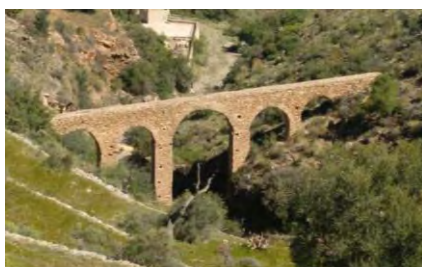
Acueducto de la Rambla del Pozo - Albánchez
